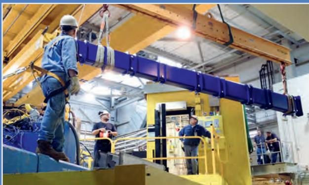
Installation eines Vakuumgehäuses
